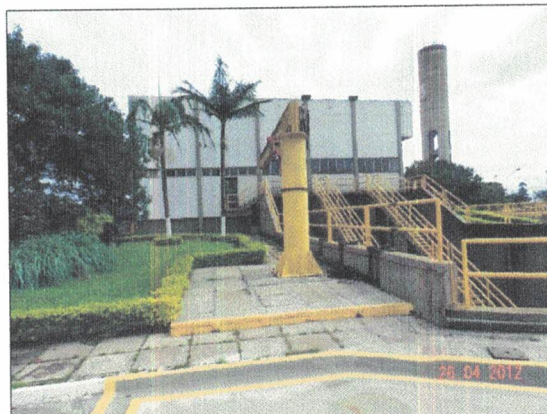
Figura 28 - Elevatória de Esgoto Final
