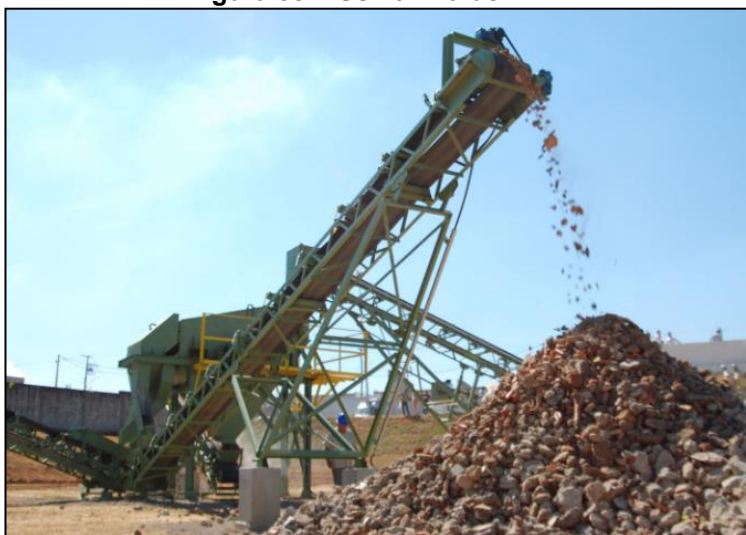
Figura 58 – Usina fixa de RCC.
