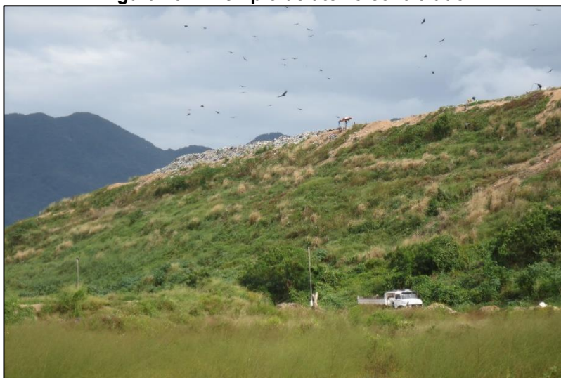
Figura 29 - Exemplo de aterro controlado.
