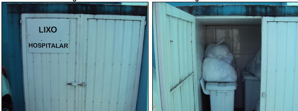
Figura 16 – Local destinado a armazenagem de RSS.
