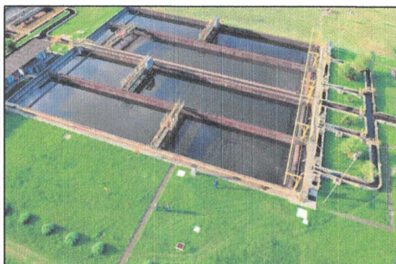
Figura 32 - Decantador primário
