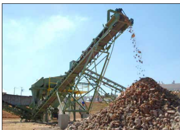
Figura 73 – Usina fixa de RCC.
