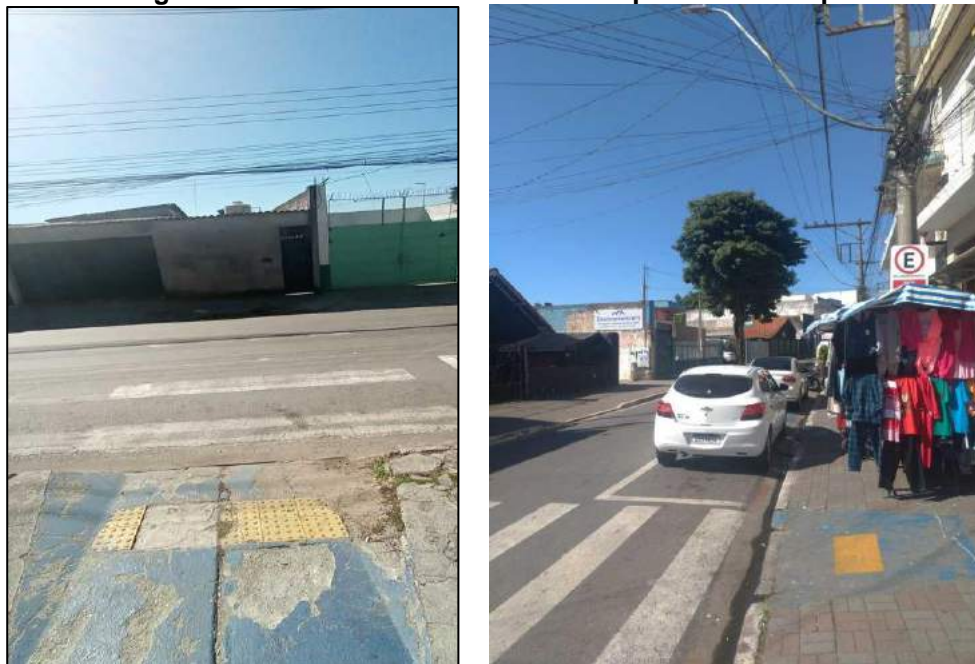
Figura 96 – Problemas verificados com piso tátil e rampa.
