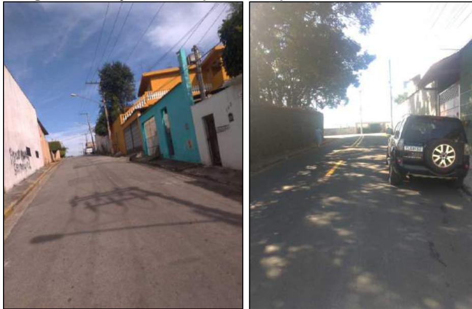
Figura 92 – Calçada fora do padrão adequado de dimensionamento.
