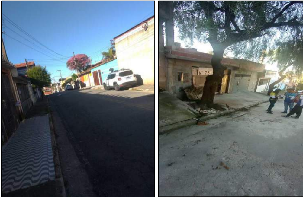
Figura 89 – Calçada com obstrução.
