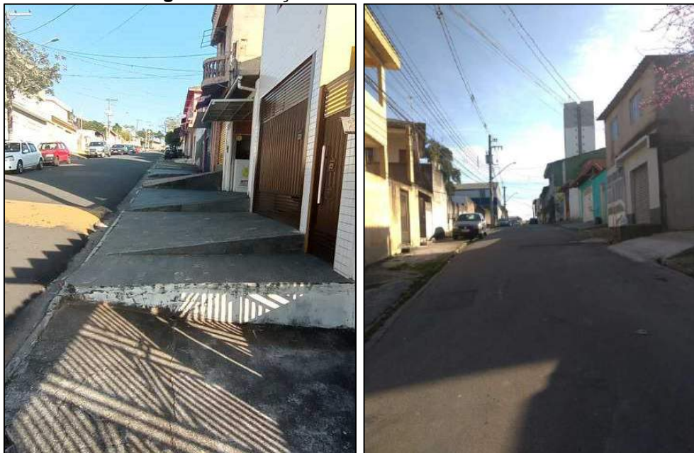
Figura 90 – Calçada com desnível acentuado.
