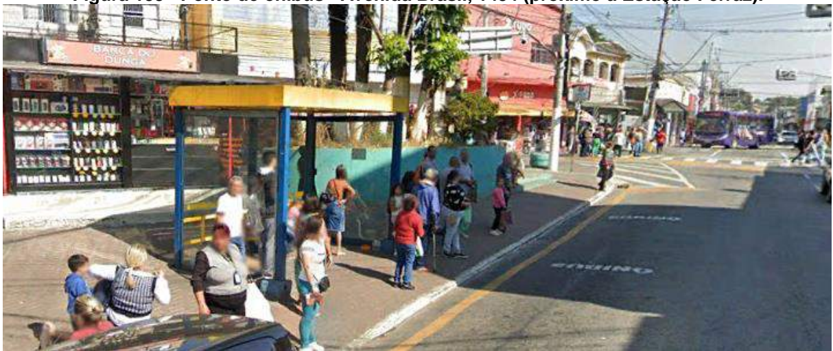
Figura 133 - Ponto de ônibus - Avenida Brasil, 1454 (próximo à Estação Ferraz).
