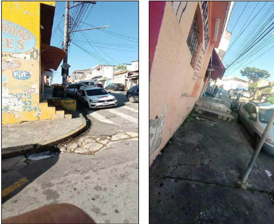
Figura 97 – Problemas encontrados nas calçadas do quadrilátero central da cidade de Ferraz de Vasconcelos
