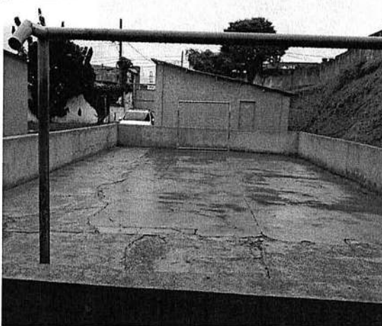
Área utilizada como quadra com piso irregular e quebrado. Ausência de tabelas, de pintura demarcatória e de tela de proteção.
