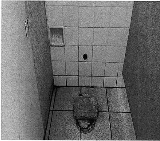
Banheiro interditado, sem vaso sanitário, tampado com pedras.
