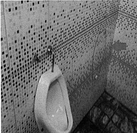
Ausência de mictório.
