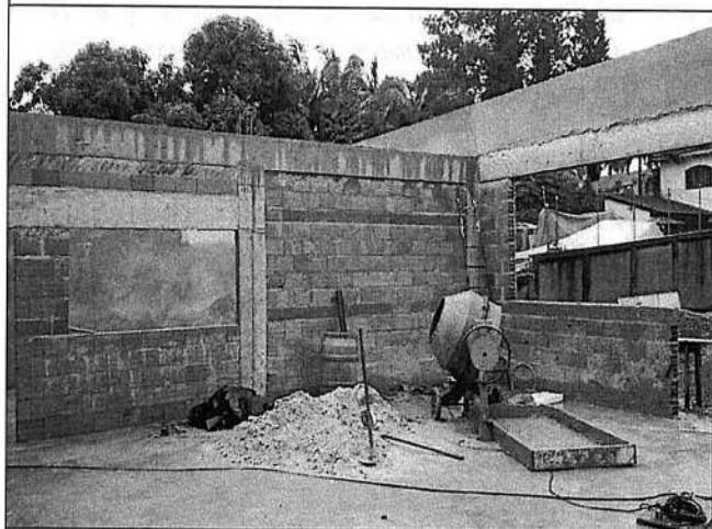
Fotos 5, 6 – Execução da alvenaria estrutural do refeitório e sanitários (em bloco cerâmico de vedação)
