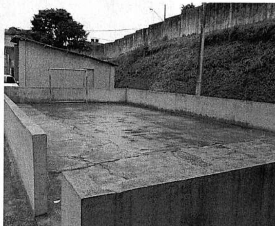
Área utilizada como quadra com piso irregular e quebrado. Ausência de tabelas, de pintura demarcatória e de tela de proteção.
