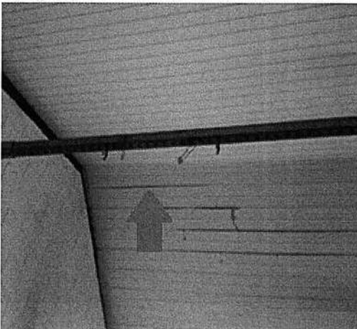
Falta de lâmpadas.
