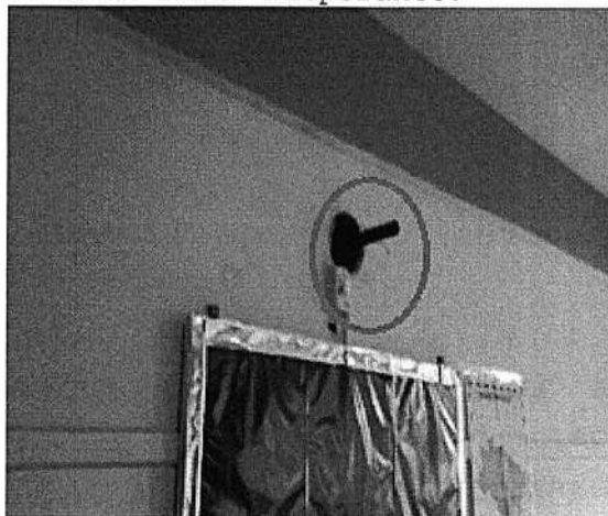
Sala de aula sem ventilador.
