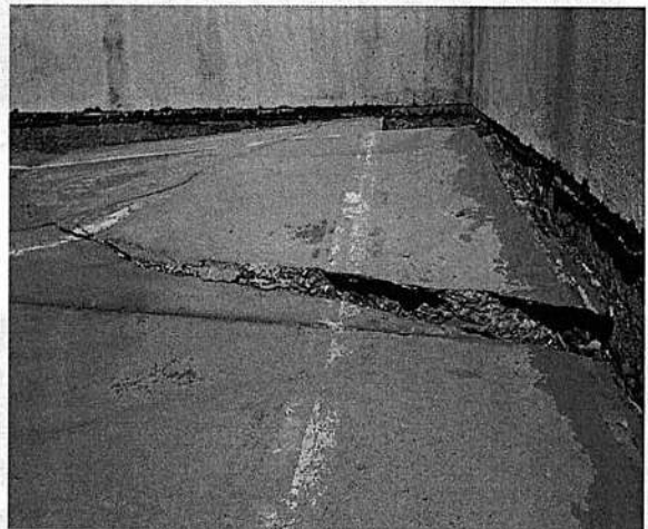
Quadra interditada com piso irregular, quebrado e afundando.
