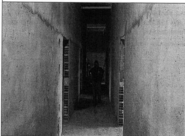
Fotos 3, 4 – Execução da alvenaria estrutural dos gabinetes (em bloco de cerâmico de vedação)
