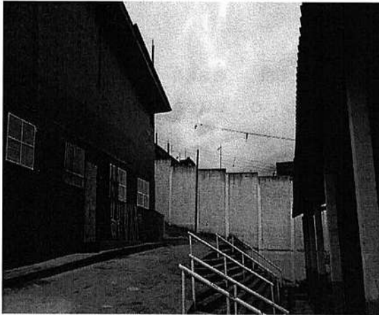
Passagem de um anexo para outro sem cobertura.
