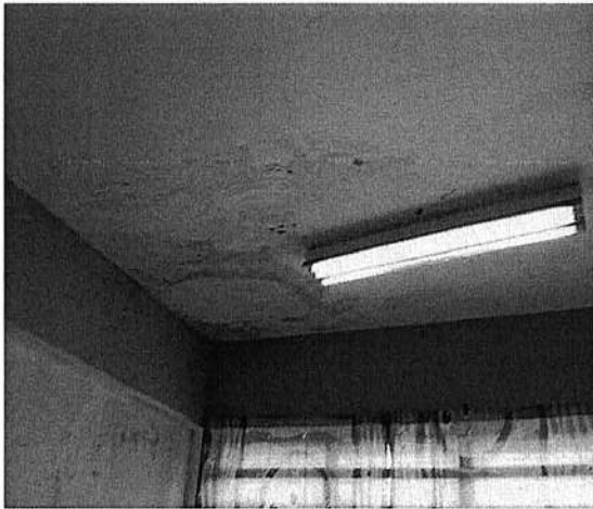
Infiltrações no teto.
