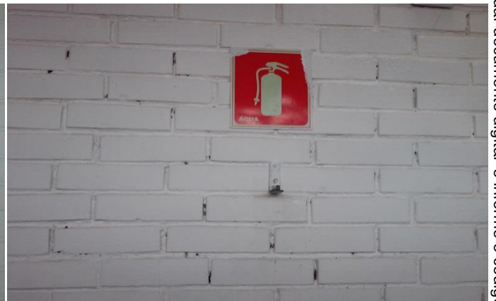
Fotos 19, 20 – Falta de extintor de incêndio
