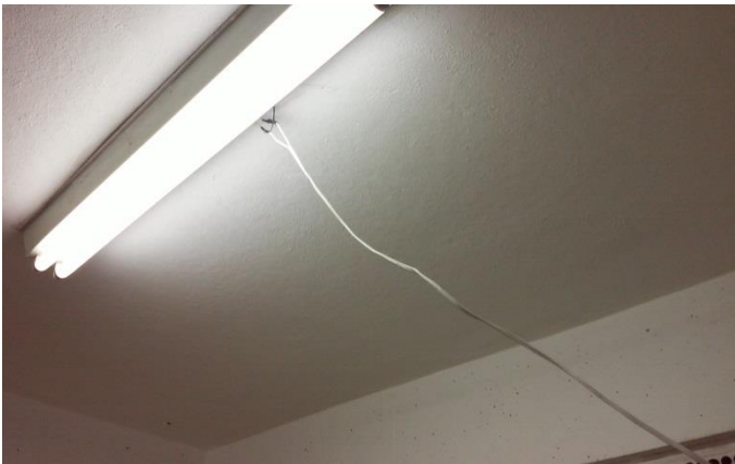
Fotos 13, 14 – Instalações elétricas improvisadas a partir de lâmpadas e com fiações expostas
