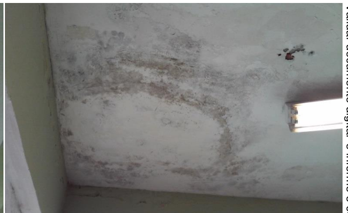
Fotos 29, 30 – Salas de aula com infiltrações no teto
