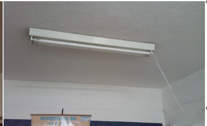
Fotos 13, 14 – Instalações elétricas improvisadas a partir de lâmpadas e com fiações expostas
