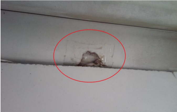
Foto 17 – Conserto de infiltração no telhado improvisado com papel contact
