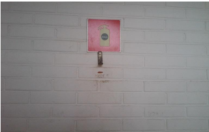
Fotos 19, 20 – Falta de extintor de incêndio
