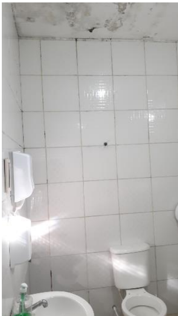
Manchas de umidade no teto
