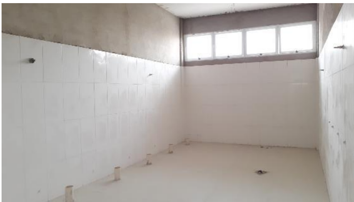
Obras dos banheiros
