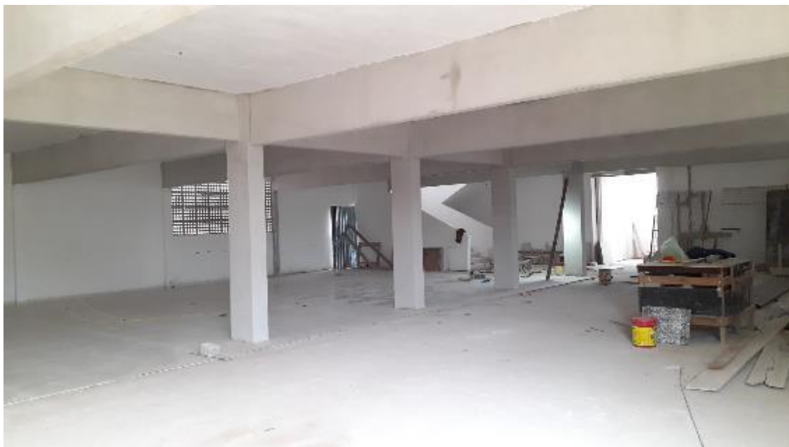
Obras do refeitório.
