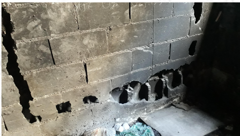
Alvenaria danificada
