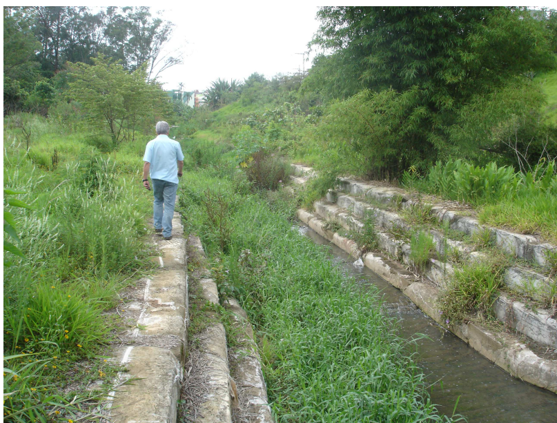
FOTO 1 – CÓRREGO TANQUE VELHO CANALIZADO – TRECHO A MONTANTE DA RUA DUQUE DE CAXIAS
