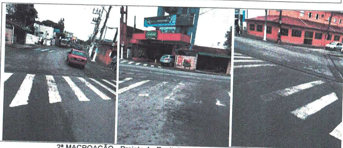
2ª MACROAÇÃO - Projeto 4 - Revitalização de sinalização horizontal 04 Faixas de travessia de pedestres (FTP-1) e 02 linhas de retenção (LRE) Endereço: Av. Pétala x Av. Florestal Foto tirada em 02-02-2018
