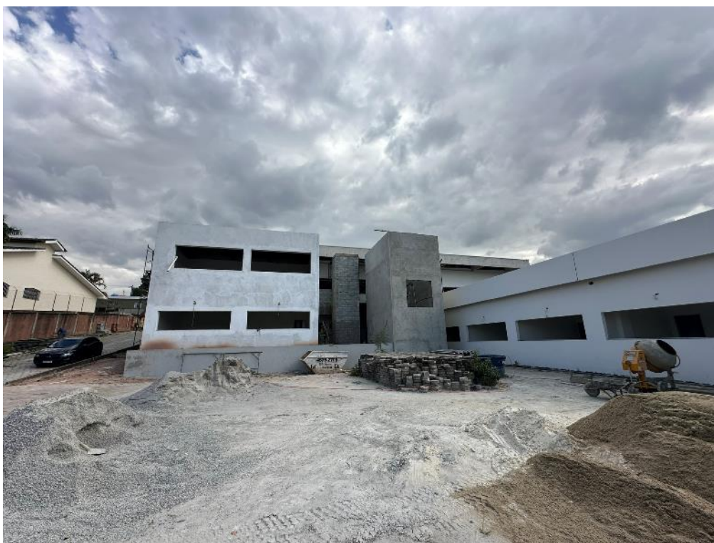
Vista parcial da parte externa da edificação.
