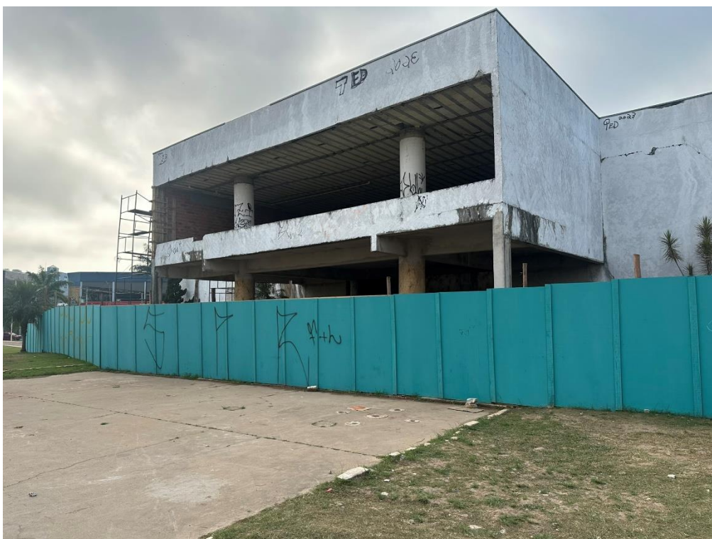
Vista parcial da fachada.
