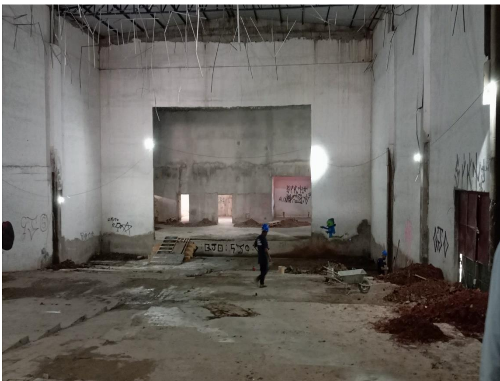
Vista parcial da parte interna da edificação.
