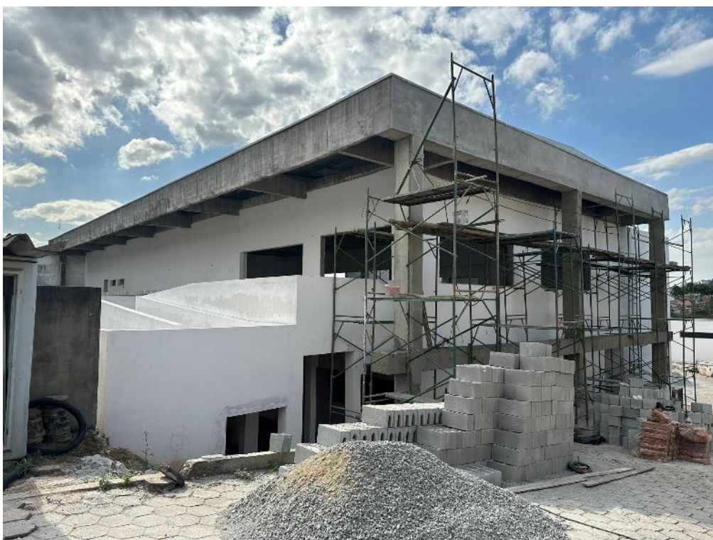
Vista parcial da parte externa da edificação.
