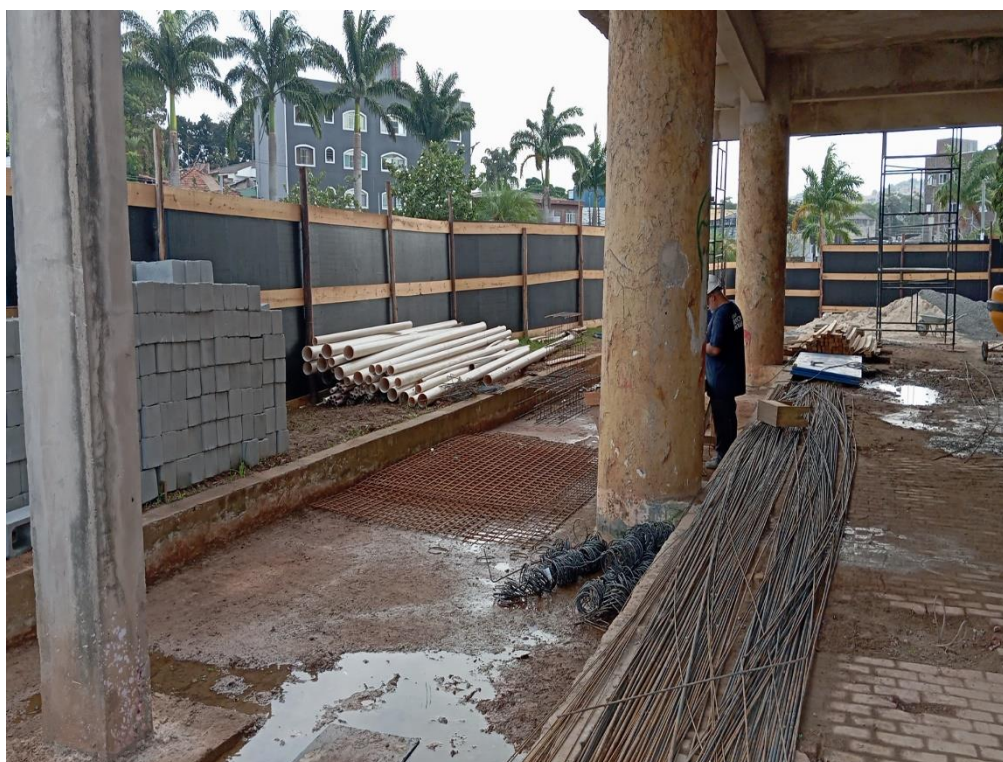
Vista parcial da entrada da edificação.
