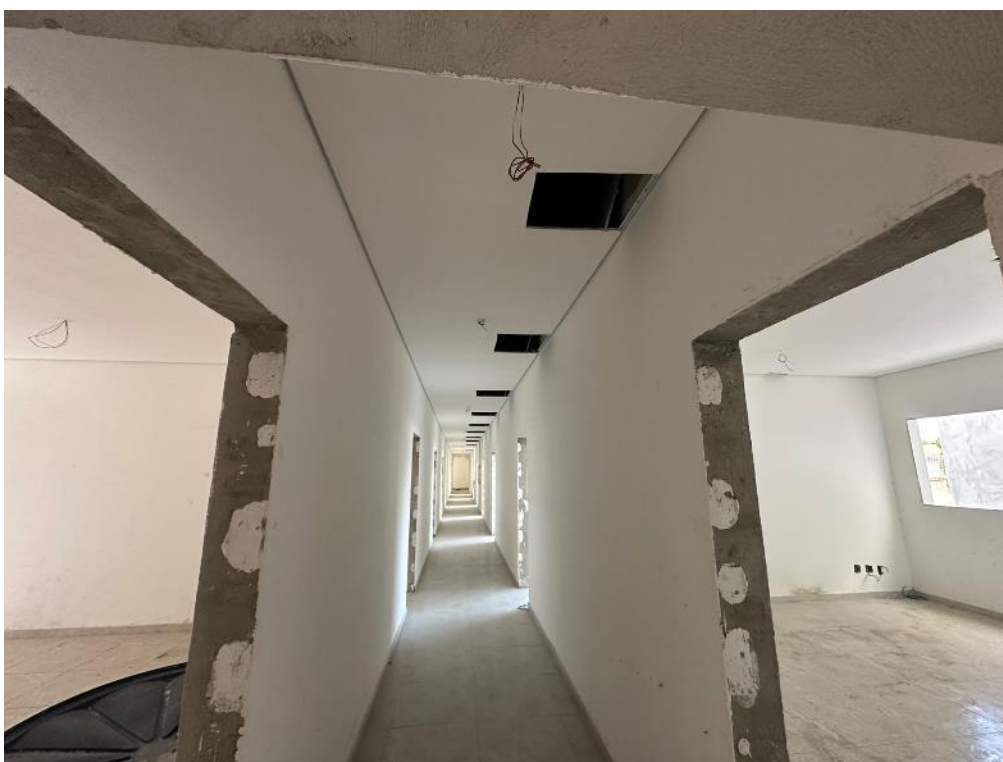
Vista parcial da parte interna da edificação.
