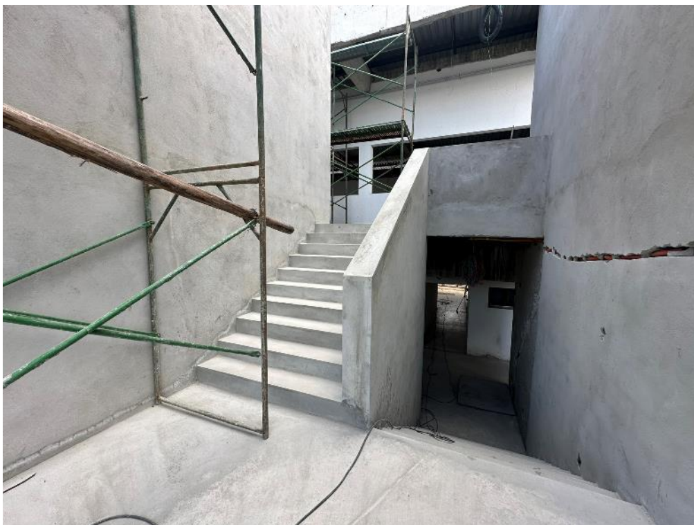
Vista parcial da parte interna da edificação.
