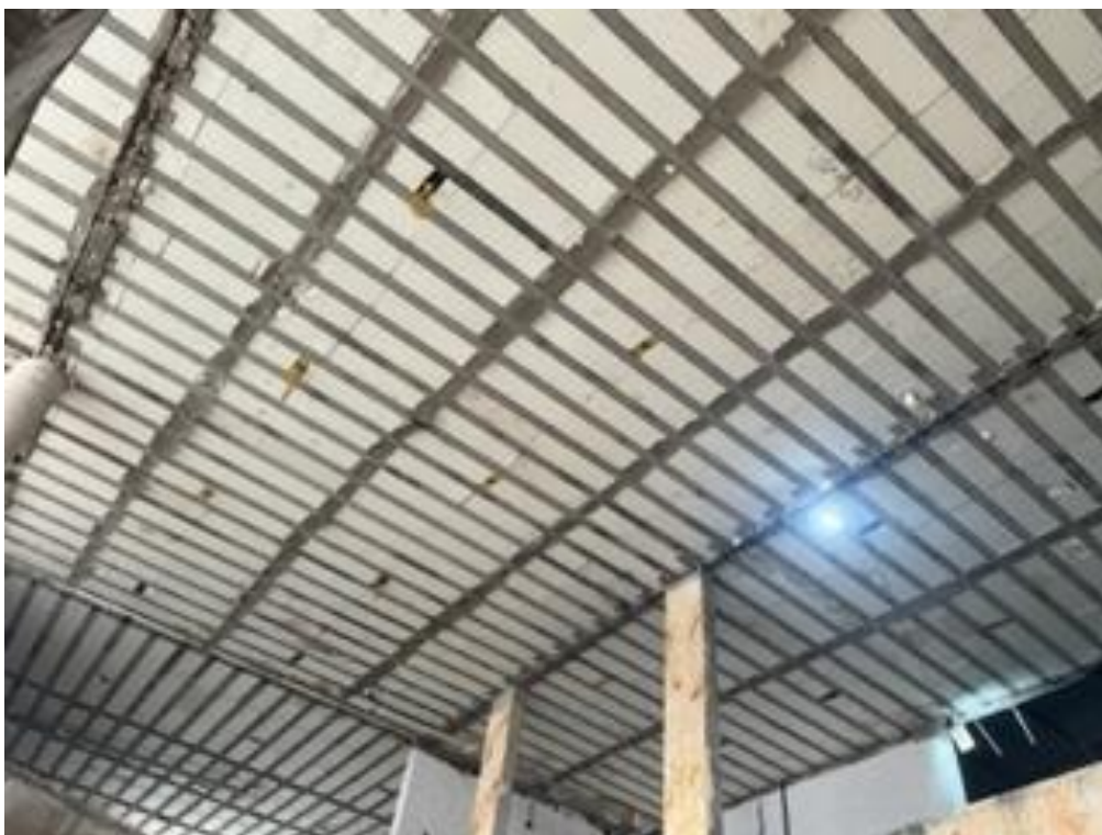
Vista parcial da cobertura que será substituída.
