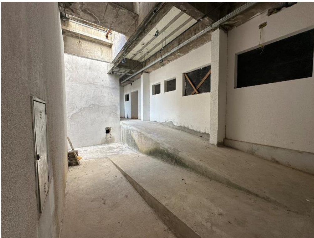
Vista parcial da parte interna da edificação.
