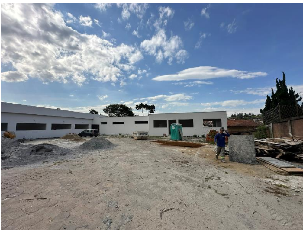
Vista parcial da parte externa da edificação.
