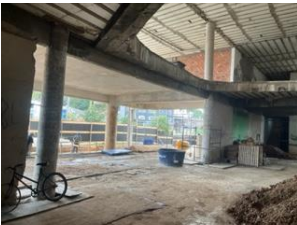
Vista parcial da parte interna da edificação.
