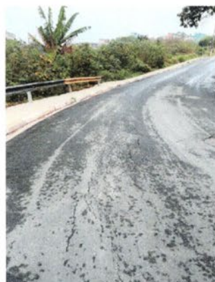
Rua Osmundo Torquato recompor pavimento e a base
