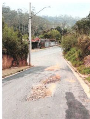
Rua João Rodrigues Dias recompor o pavimento e a base
