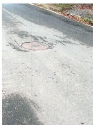
Rua João Rodrigues Dias levantar o Póço de Visita - PV e recompor o pavimento
