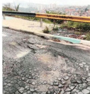
Rua Osmundo Torquato recompor pavimento e a base
